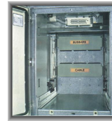
NVBS斷路器室於移去斷路器後，其帶電之連接接頭被金屬遮板遮住，因此此單元室即受到保護。
